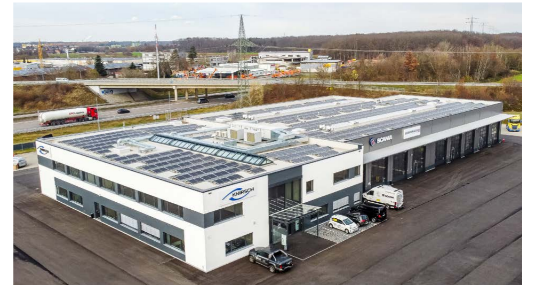
A SUCURSAL DE SCHUTTERWALD FICA MESMO AO LADO DA AUTO-ESTRADA A5. Os seus painéis solares e um sistema de recuperação de calor conferem-lhe um carácter particularmente ecológico
