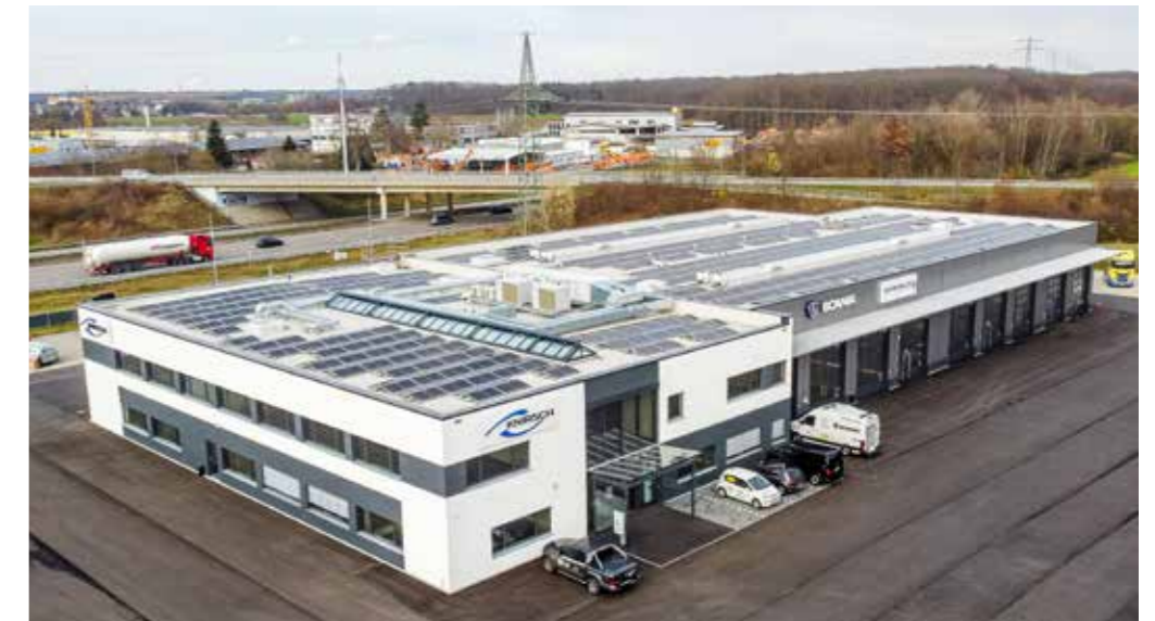
DER STANDORT SCHUTTERWALD LIEGT DIREKT AN DER AUTOBAHN A5 und ist dank Photovoltaikanlage und Abwärmenutzung besonders umweltfreundlich.
